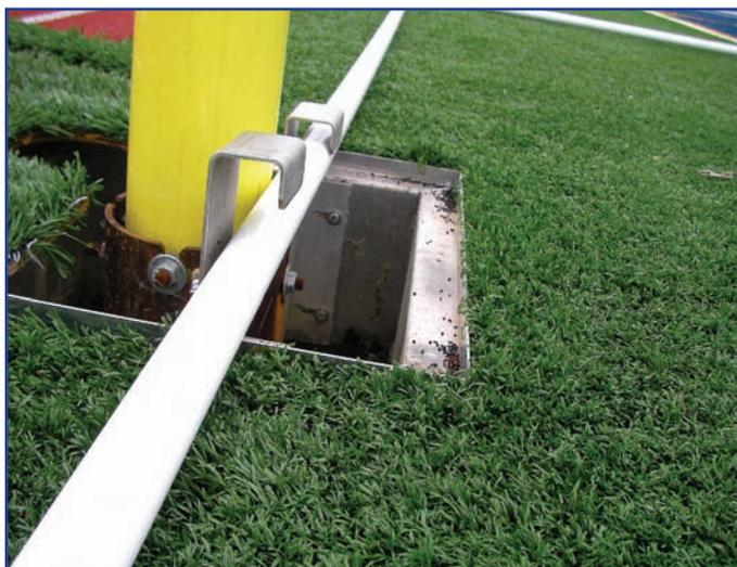
El arco se desliza perfectamente debajo de los sujetadores del trinquete
